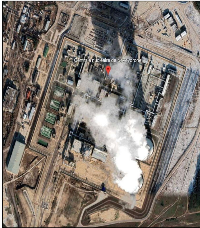
Novovoronezh nuclear plant, Voronezh Oblast, central Russia
